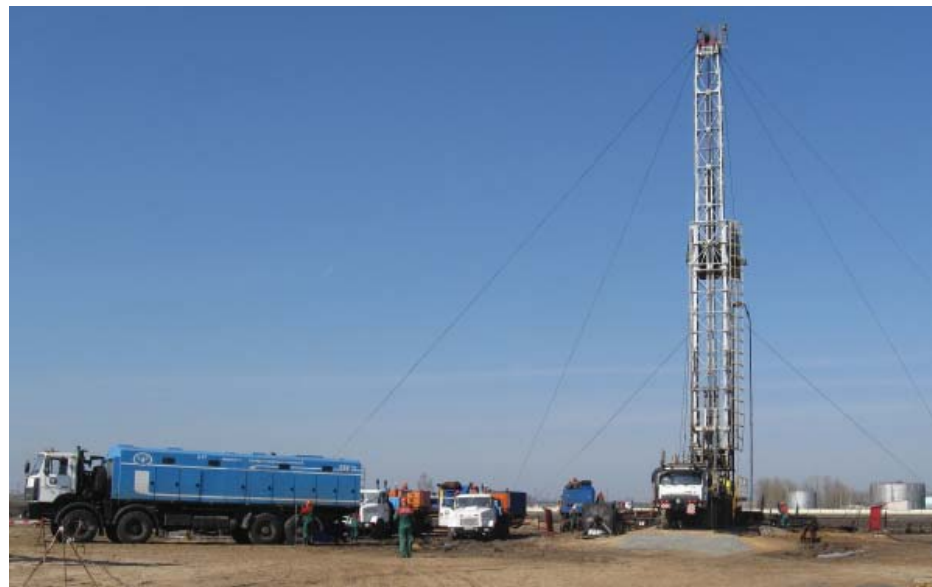
Азотная компрессорная станция ТГА-20/251 С95 во время выполнения работ
